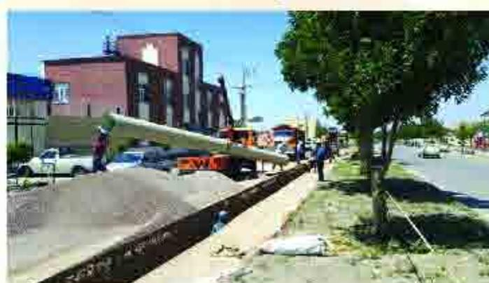
**تذکر:** نیروی تقریبی برای جا رفتن لوله ها ۱ کیلوگرم برای هر میلی متر قطر می باشد. گاهی می توان لوله های کم قطر را بدون استفاده از **تیغه** جازد، استفاده از **اهرم** در این صورت میتواند روش مفیدی باشد.
